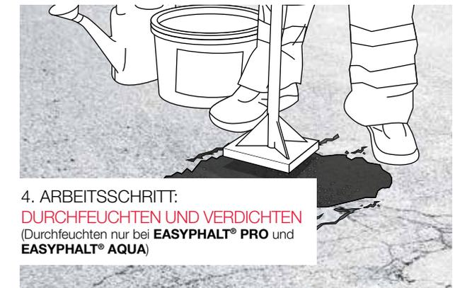
**EASYPHALT® PRO** und **EASYPHALT® AQUA** mit etwas Wasser durchfeuchten (ca. 5 Liter Wasser je 25 kg-Eimer). Alle **EASYPHALT®**-Produkte mit einer Walze, Rüttelplatte oder Handstamper verdichten. Die Fläche kann unmittelbar nach dem Einbau für den Verkehr freigegeben werden.
